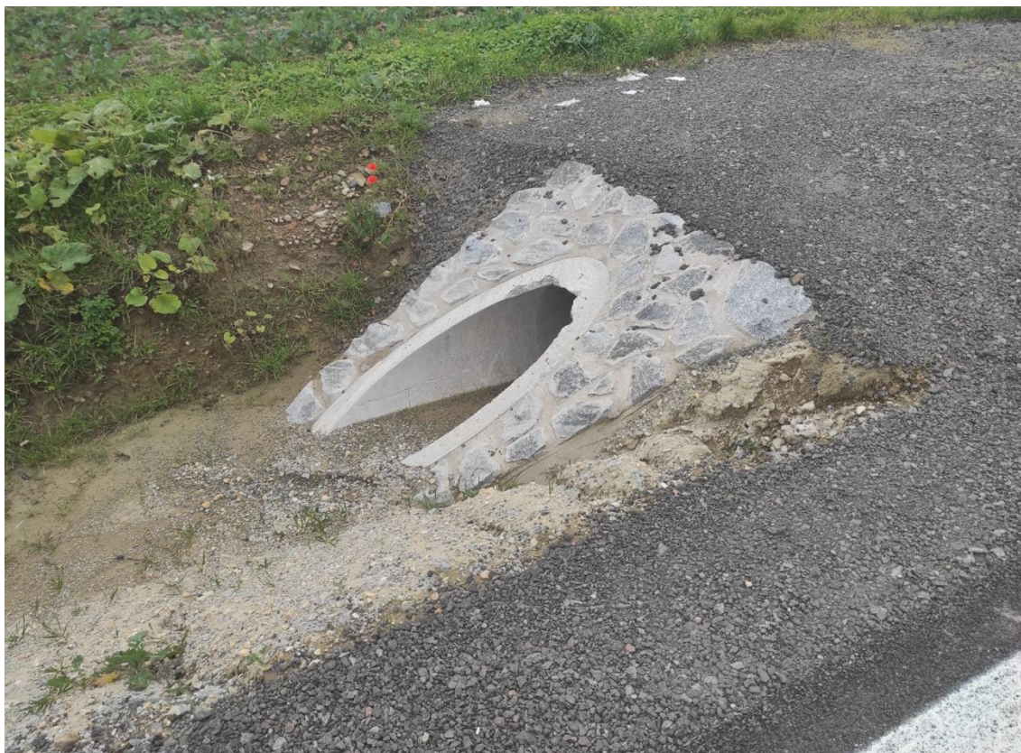
Obrázek 4: Příklad provedení vtoku a výtoku propustku se šikmým čelem pod hospodářským sjezdem
